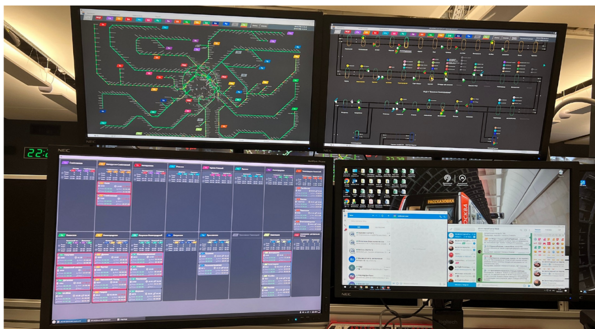
Рис. 20. Рабочее место диспетчера центра транспортного управления Московского метрополитена
